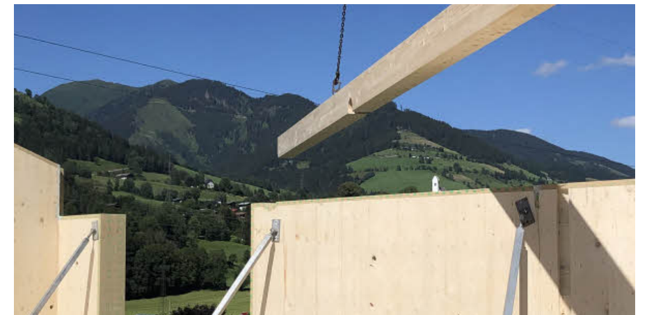
Kurze Produktions- und Bauzeiten durch präzise vorgefertigte Bauteile der leim- und chemiefreien Meissnitzer Massiv-Holz-Mauer®
